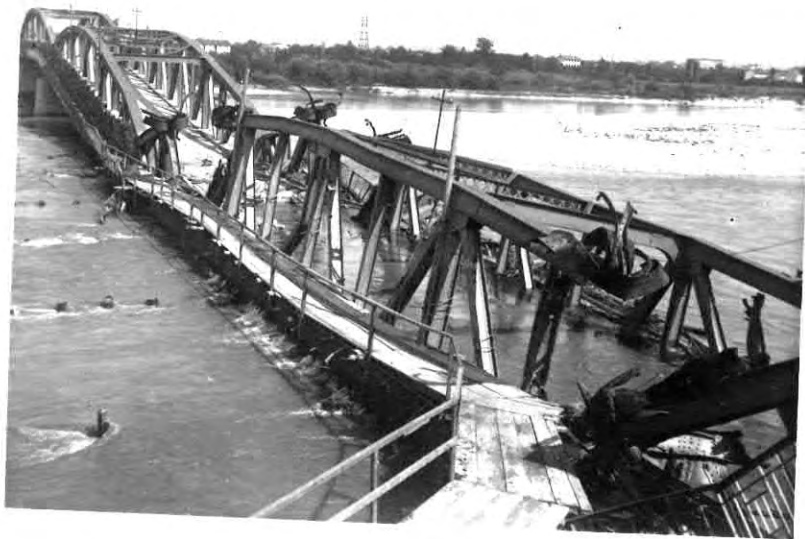
Il ponte di ferro.
